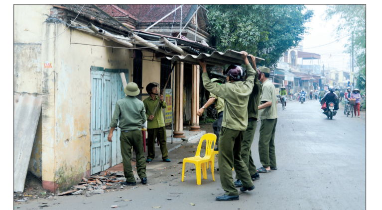
Tháo dỡ mái che, mái vẩy tại xã Hồng Minh (Hưng Hà).
