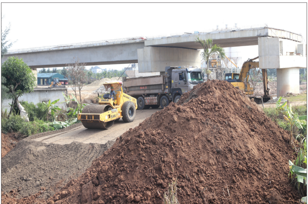
Thi công hoàn thiện đường tránh đê tuyến đường bộ ven biển tại vị trí mới được bàn giao mặt bằng bố sung địa phận xã Nam Phú (Tiên Hải).
