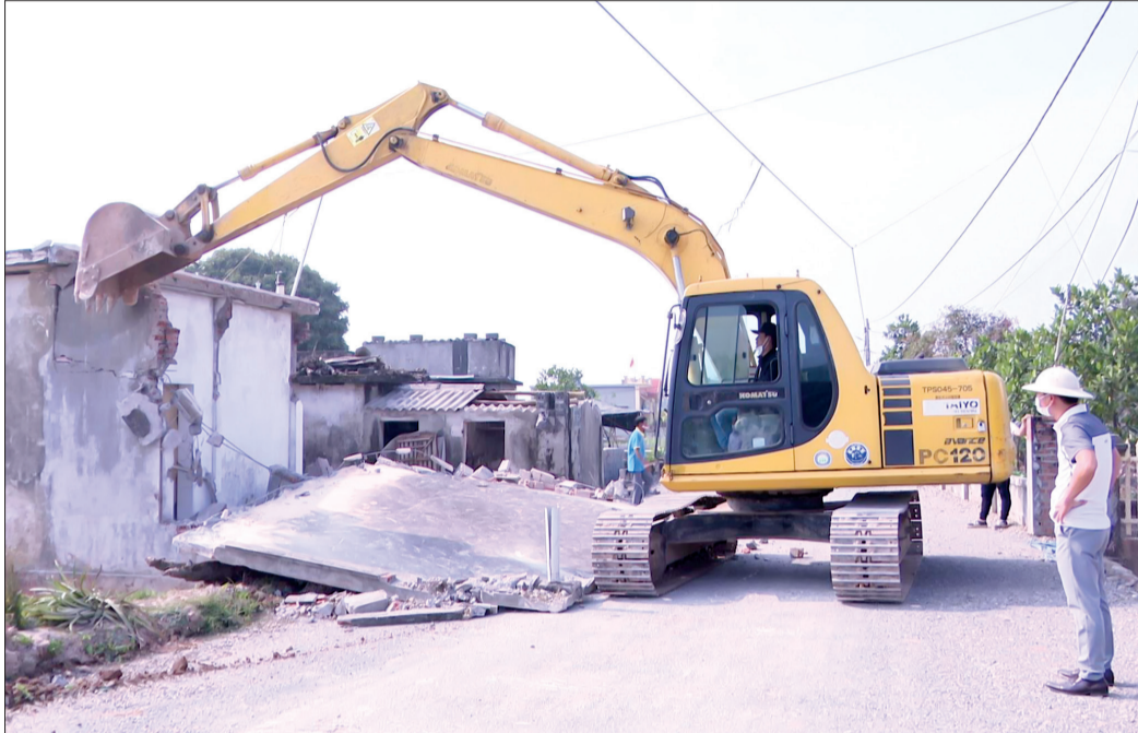
Giải phóng mặt bằng tuyến đường đi qua địa bàn xã Bình Định (Kiến Xương).
