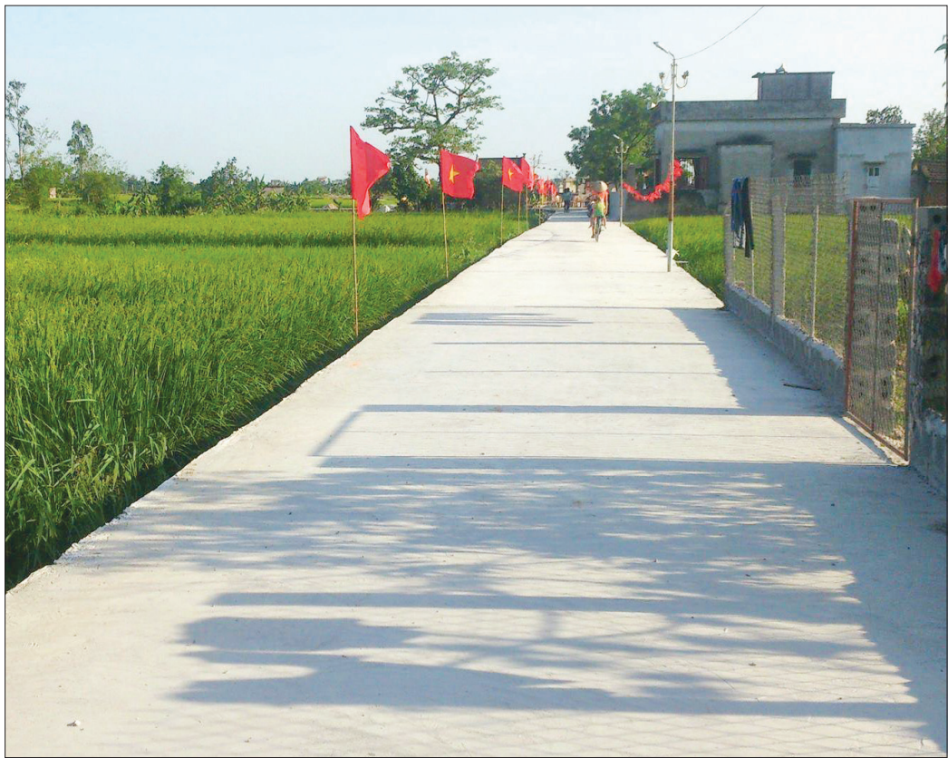
Tuyến đường nội đồng được bê tông hóa ở xã An Bình (Kiến Xương).
