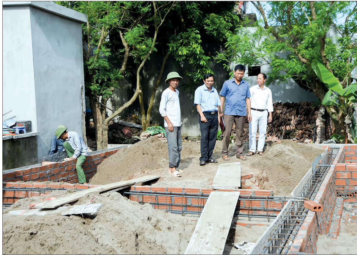
Kiểm tra tiến độ xây dựng nhà ở cho người có công tại xã Tân Phong (Vũ Thư).
