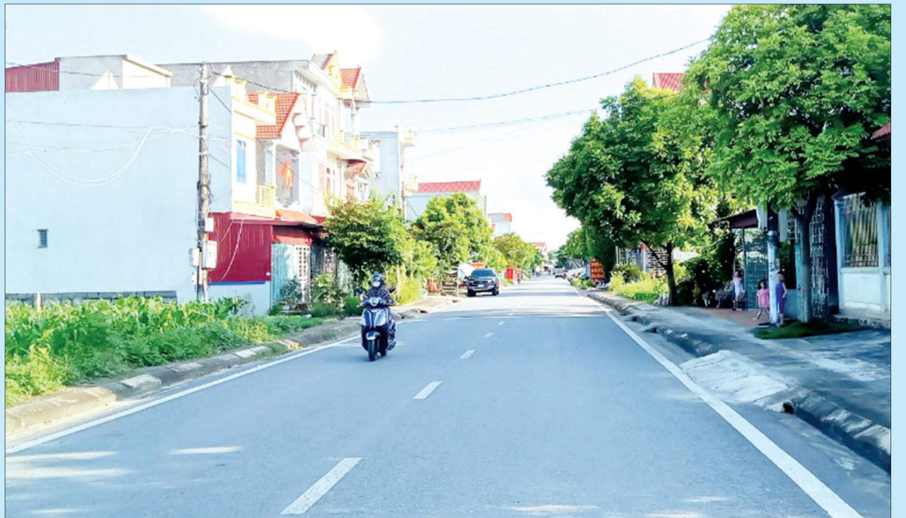
Đường nông thôn mới ở Hưng Hà được xây dựng khang trang.
