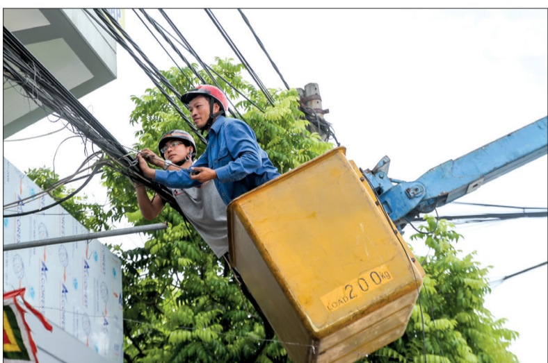
Cán bộ kỹ thuật các doanh nghiệp viễn thông xử lý cáp viễn thông không sử dụng.
