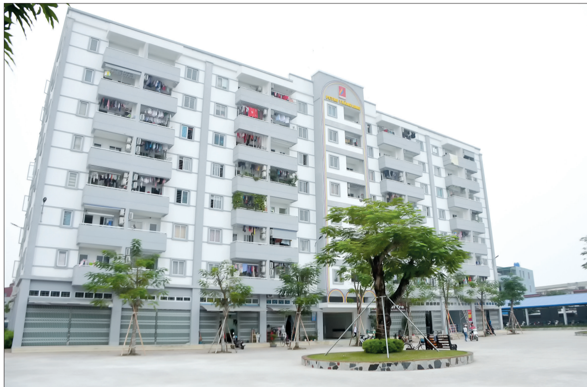
Khu nhà ở xã hội trên địa bàn thành phố Thái Bình.
