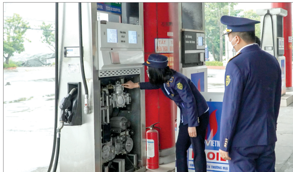
Lực lượng quản lý thị trường tăng cường kiểm tra, giám sát hoạt động kinh doanh xăng dầu trên địa bàn tỉnh. Trong ảnh: Cán bộ Đội Quản lý thị trường số 2 kiểm tra kẹp chì tại một cột bơm xăng.
