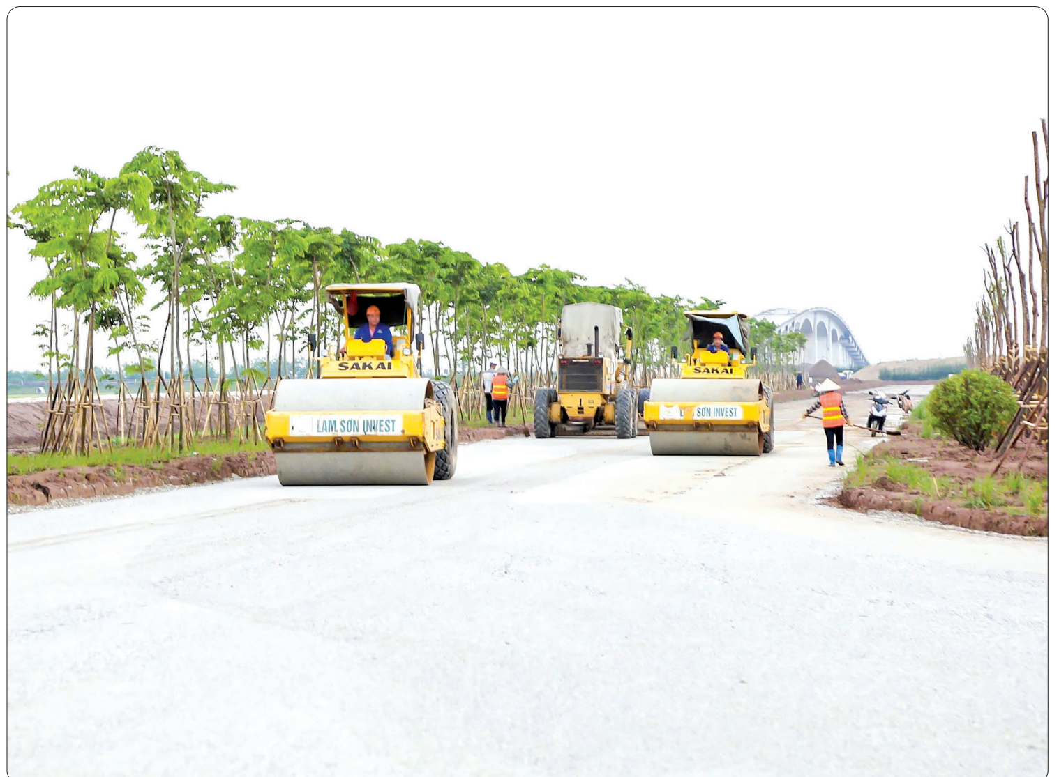
Thi công hạ tầng khu công nghiệp Hải Long (Tiên Hải).
