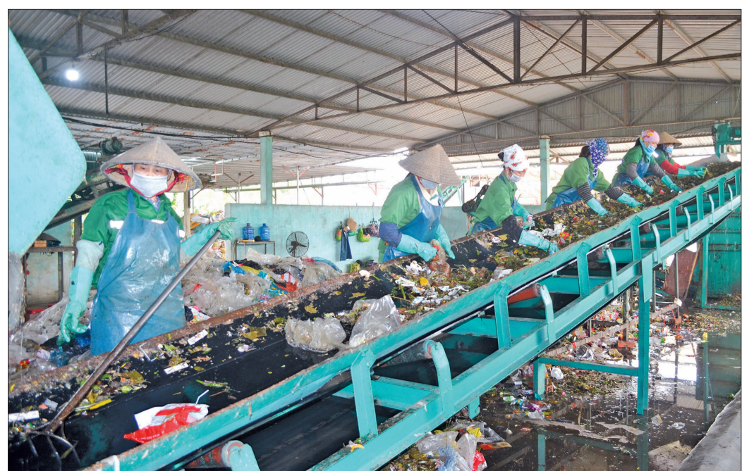
Khu phân loại rác thải sinh hoạt của Công ty.
