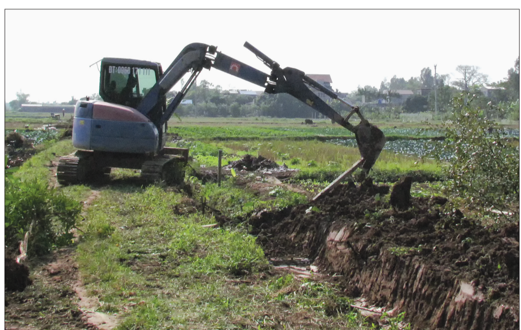
Đào đắp kênh mương nội đồng trước mùa mưa, bão.
