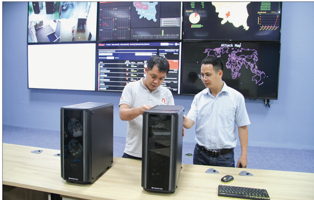
Cán bộ Sở Thông tin và Truyền thông lắp đặt thiết bị tại Trung tâm điều hành an toàn, an ninh thông tin tại tỉnh Thái Bình.
