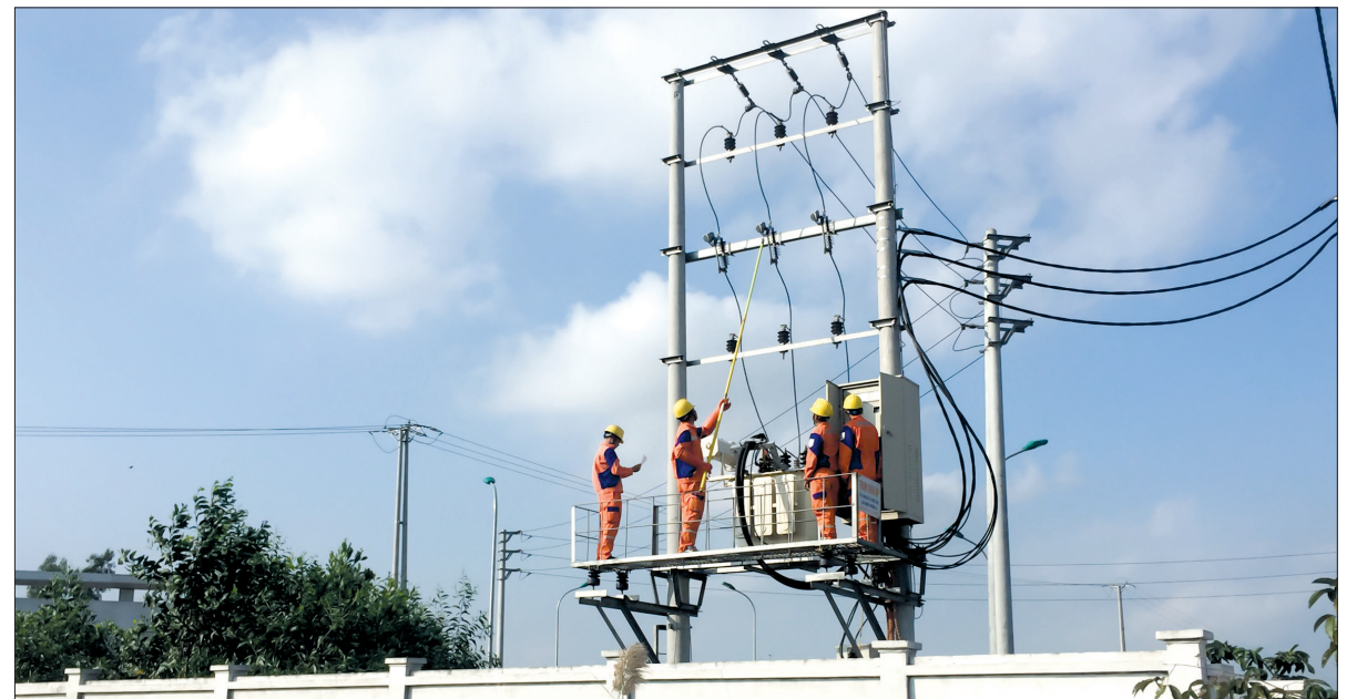
Nhân viên Công ty Điện lực Thái Bình kiểm tra, sửa chữa hệ thống điện.
