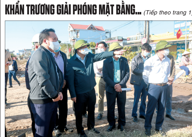
Đồng chí Nguyễn Quang Hưng, Ủy viên Ban Thường vụ Tỉnh ủy, Phó Chủ tịch thường trực UBND tỉnh kiểm tra tiến độ thi công dự án cải tạo, nâng cấp đường 221A đoạn qua xã Nam Hưng (Tiên Hải).
