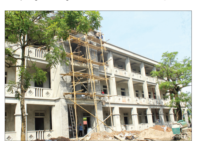
Xã Bách Thuận đẩy nhanh tiến độ thi công xây dựng Trường Tiểu học Bách Thuận để chuẩn bị đón năm học mới.
