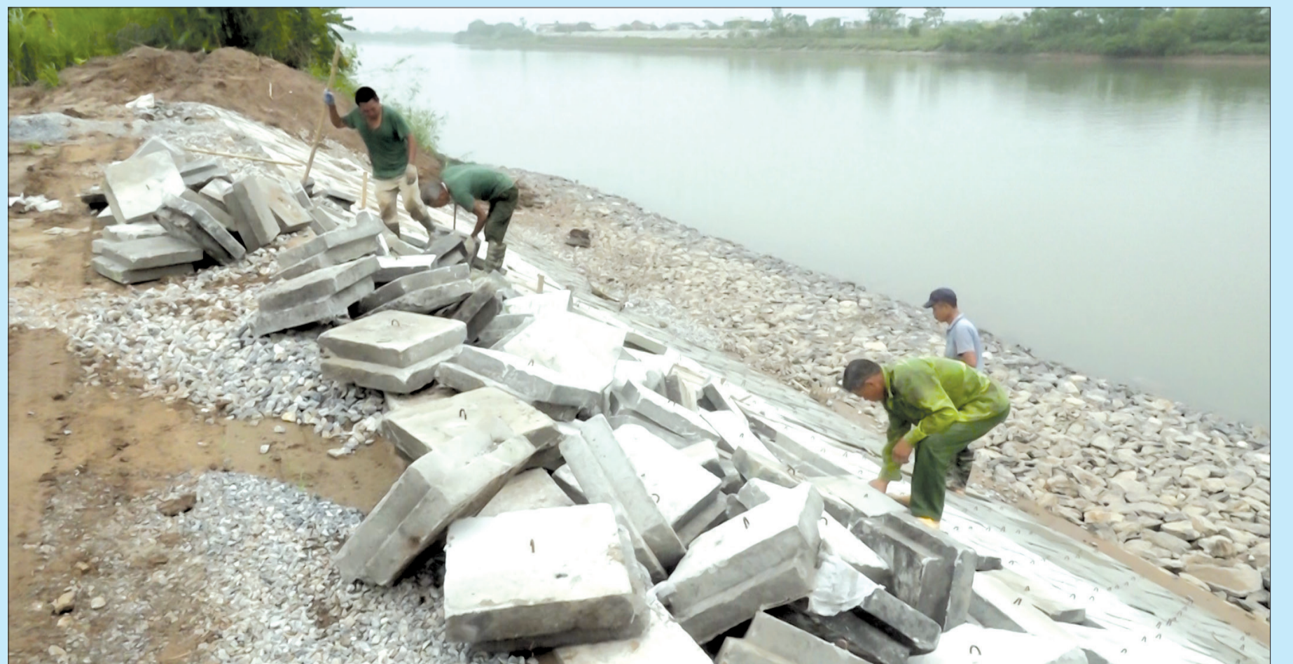
Công trình đê, kè được đầu tư nâng cấp.
