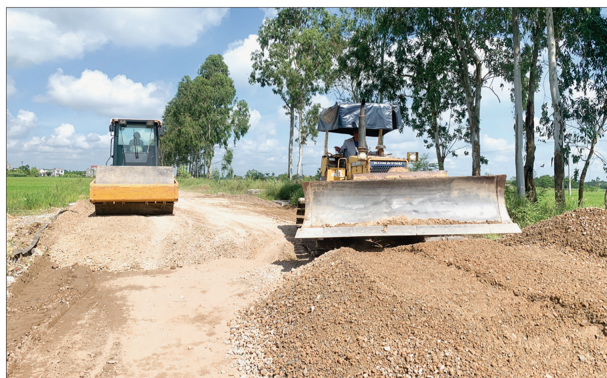
Thi công dự án nâng cấp, cải tạo đường ĐH.65A, ĐH.65B huyện Hưng Hà, đoạn từ quốc lộ 39 (Km46+100) đi đường ĐH.59 đi di tích lịch sử quốc gia đến Tiên La giai đoạn 1.
