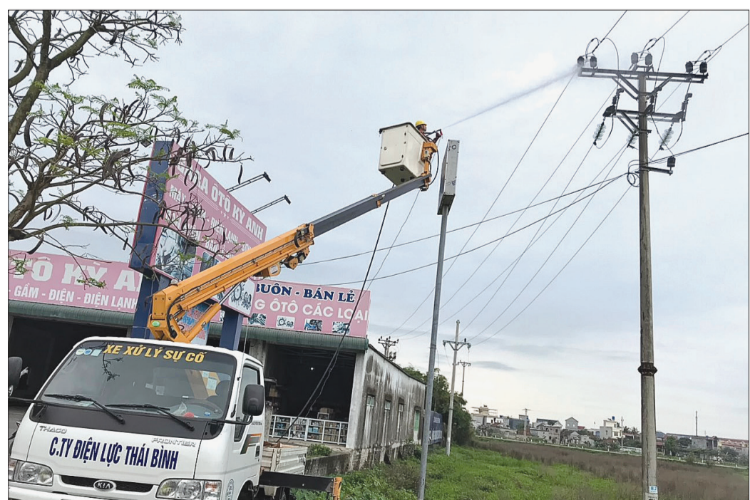
Điện lực Đông Hưng rửa sứ cách điện bằng nước áp lực cao để không gây gián đoạn việc cung cấp điện.
