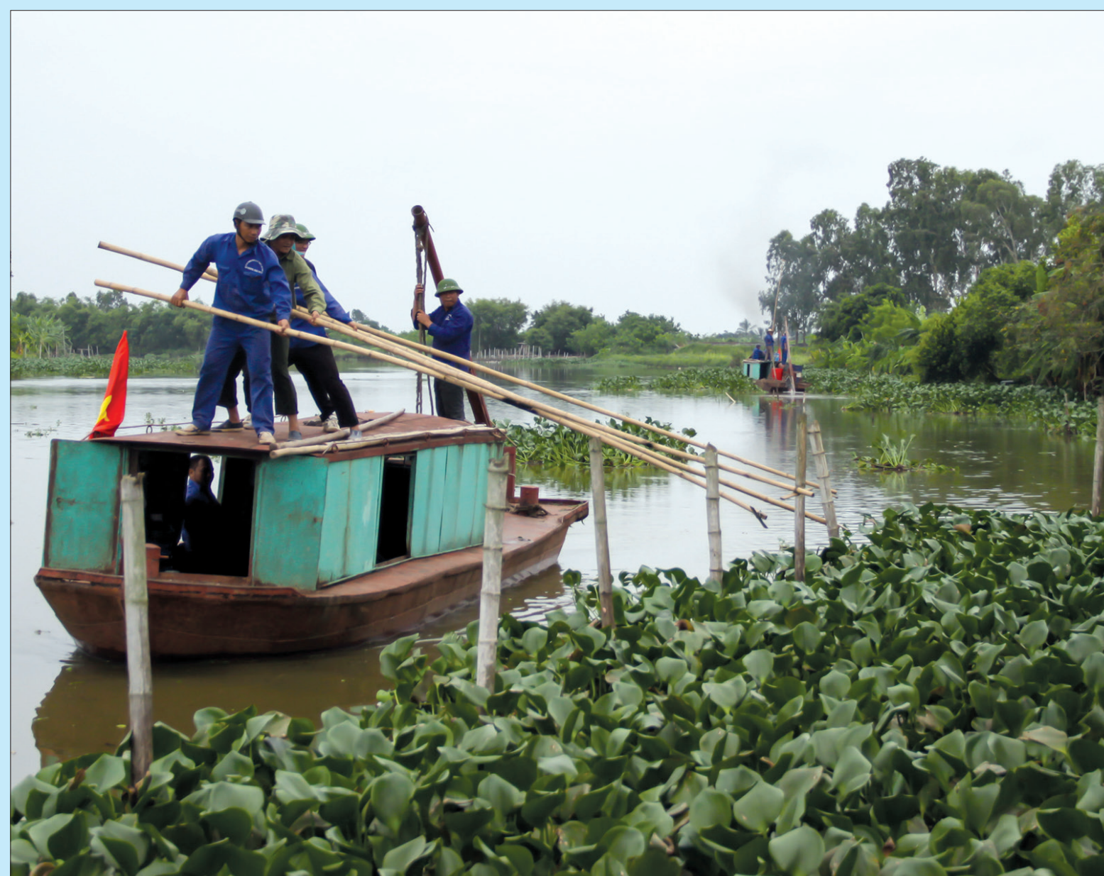
Công nhân Công ty TNHH Một thành viên Khai thác công trình thủy lợi Bắc Thái Bình giải tỏa dòng chảy.
