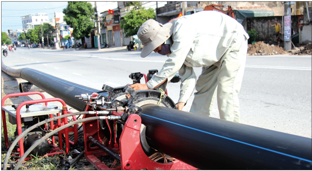
Công nhân Công ty Cổ phần Nước sạch Thái Bình sử dụng thiết bị hàn nhiệt hiện đại để nối ống nước.
