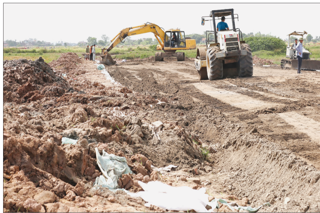
Dự án tuyến đường bộ ven biển đoạn qua xã Thụy Tân (Thái Thụy) đang được thi công.
