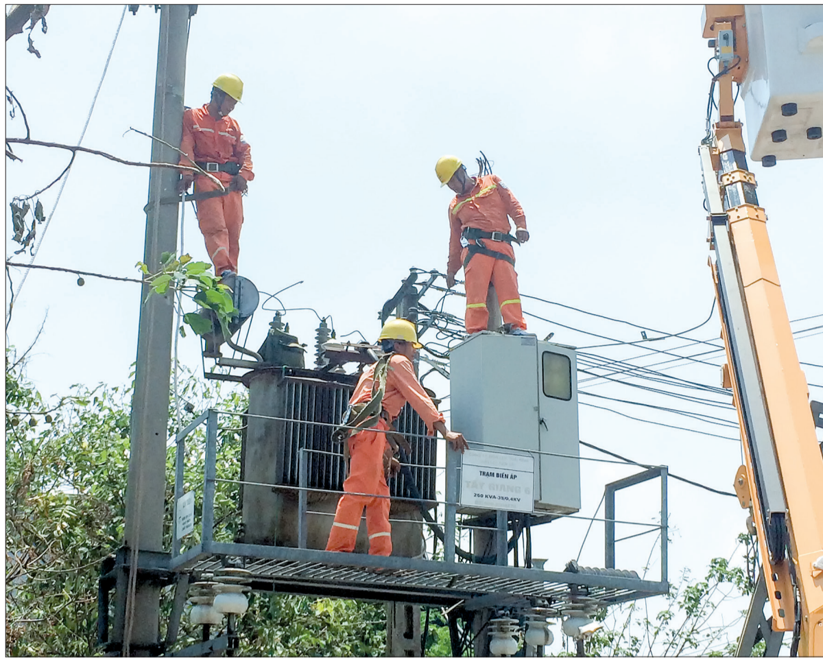
Công ty Điện lực Thái Bình tổ chức khắc phục nhanh sự cố về điện.
