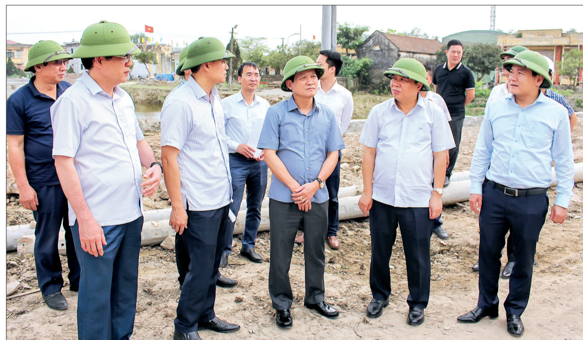
Đồng chí Nguyễn Quang Hưng, Ủy viên Ban Thường vụ Tỉnh ủy, Phó Chủ tịch thường trực UBND tỉnh kiểm tra tiến độ thi công dự án cải tạo, nâng cấp đường tỉnh 455, đoạn qua xã Đông Tiến (Quỳnh Phụ).
