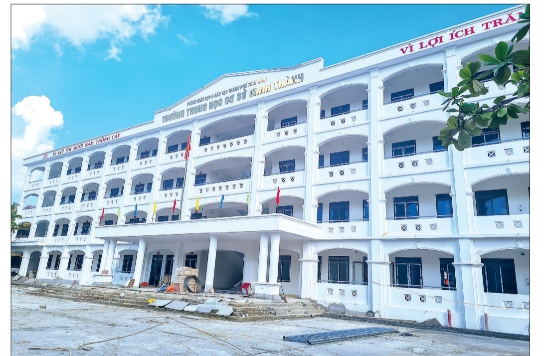
Công trình nhà học 4 tầng của Trường THCS Minh Thành đã cơ bản hoàn thành.
