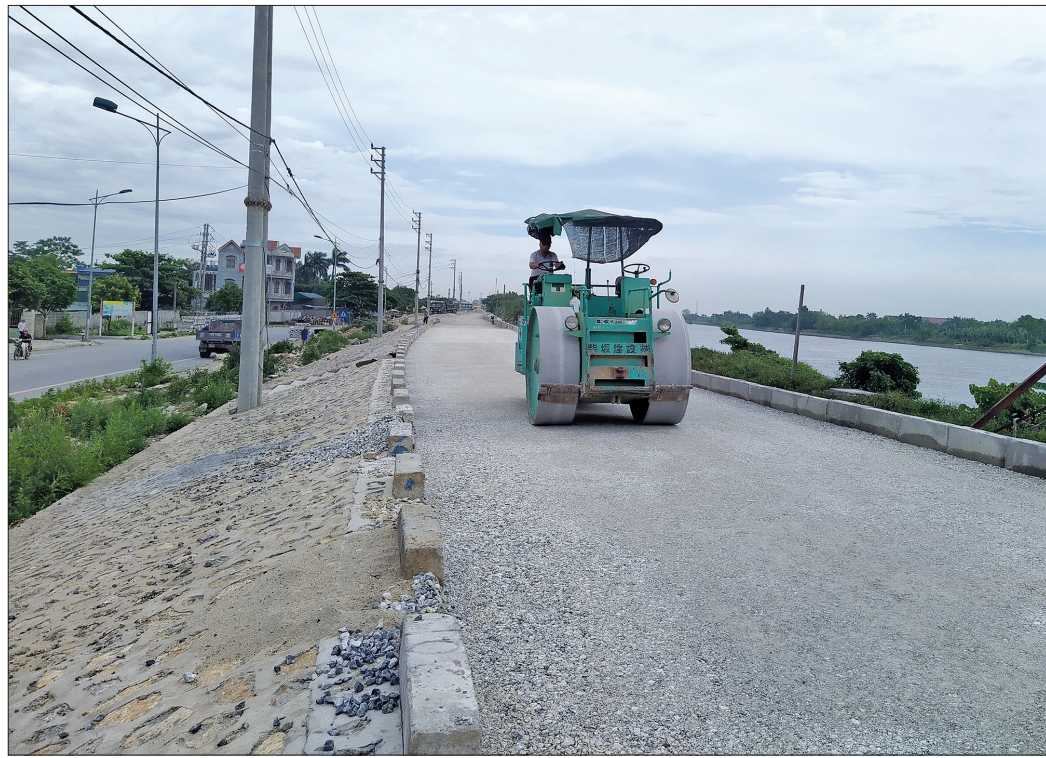
Thi công đê sông Trà Lý đoạn qua địa phận phường Bồ Xuyên, thành phố Thái Bình.
