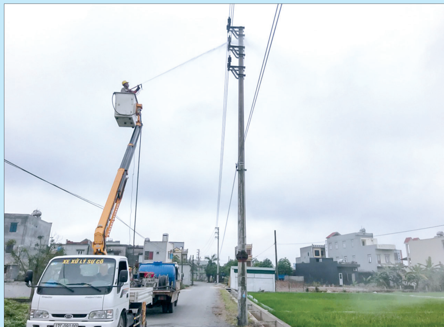
Điện lực Kiến Xương bảo dưỡng đường dây.
