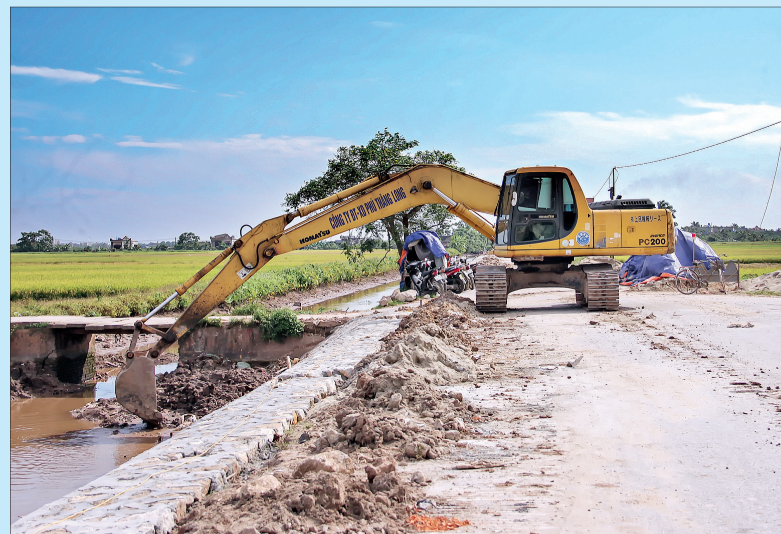
Thi công kè mái chống sạt lở đường 7 (DH.35) đoạn qua xã Nam Chính (Tiền Hải).
