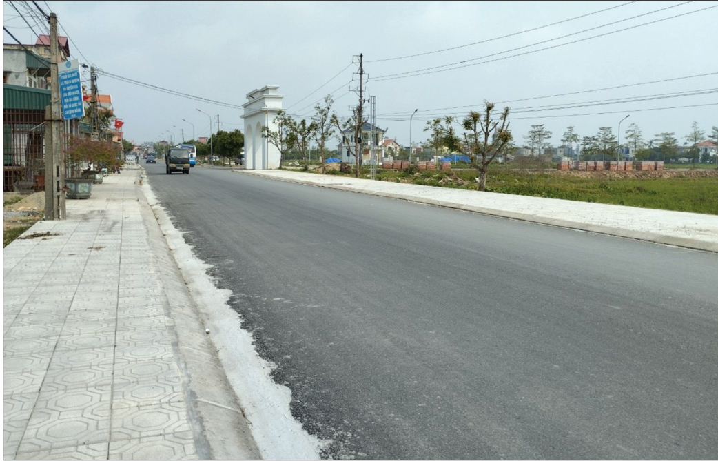
Thời gian qua, Đảng ủy, Ủy ban Kiểm tra Đảng ủy xã Tây Ninh (Tiền Hải) thường xuyên chú trọng giám sát các công trình xây dựng trên địa bàn, trong đó có hệ thống đường giao thông.
