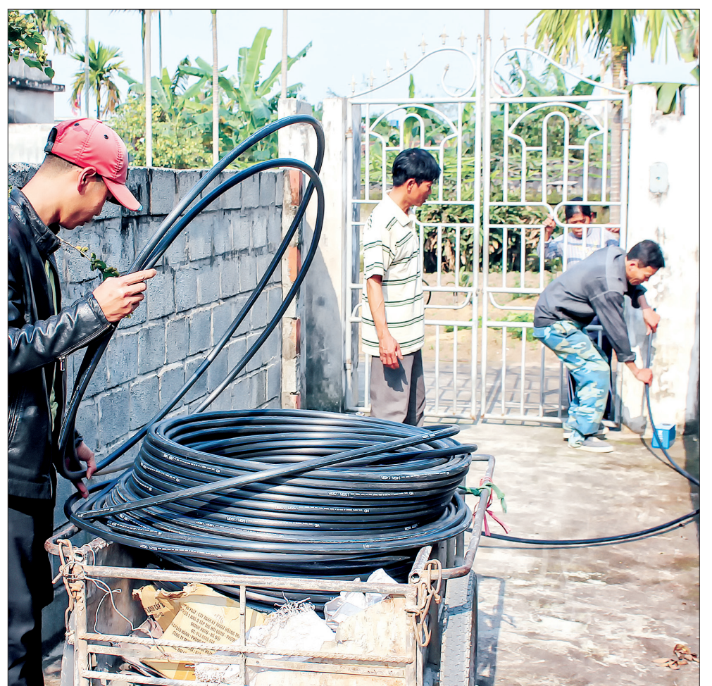
Lắp đặt đường ống dẫn nước tới hộ dân.
