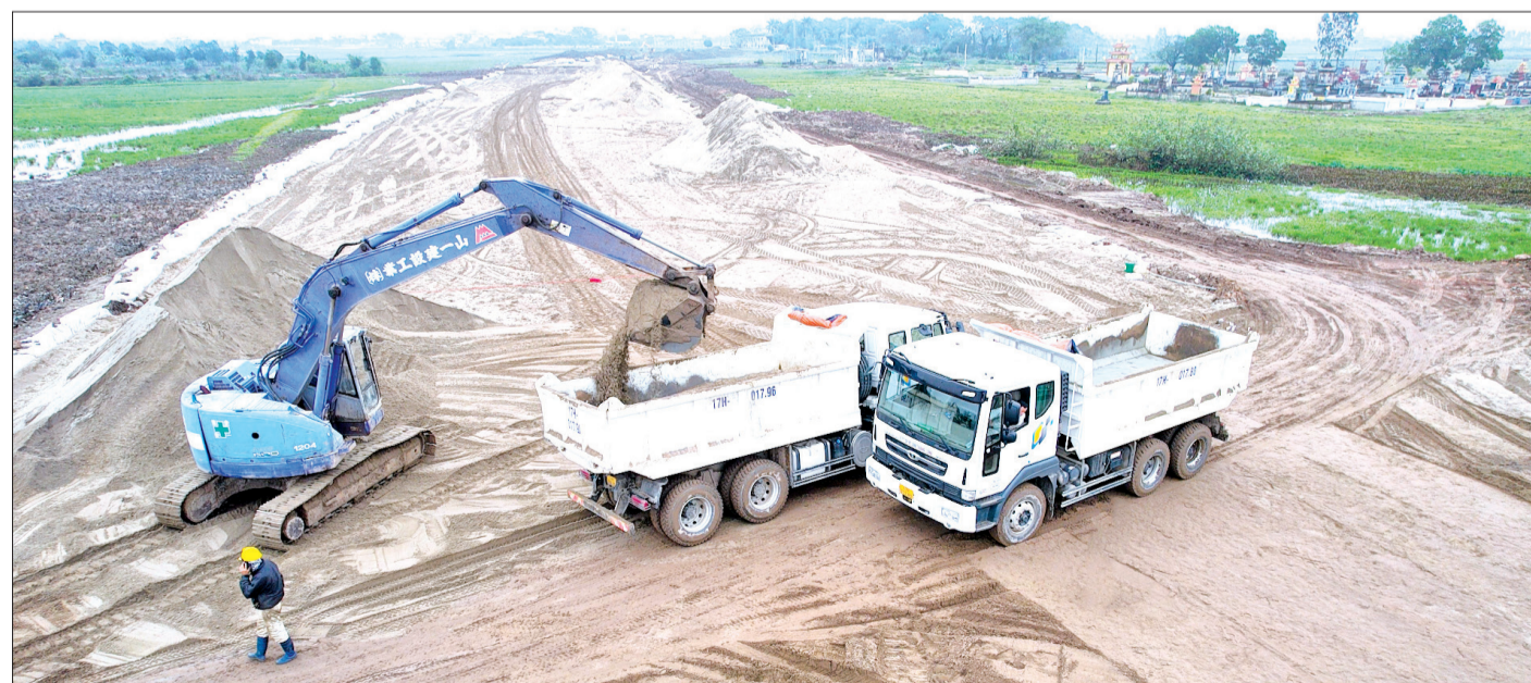
Thi công nền đường đoạn qua địa phận xã Song An (Vũ Thư).
