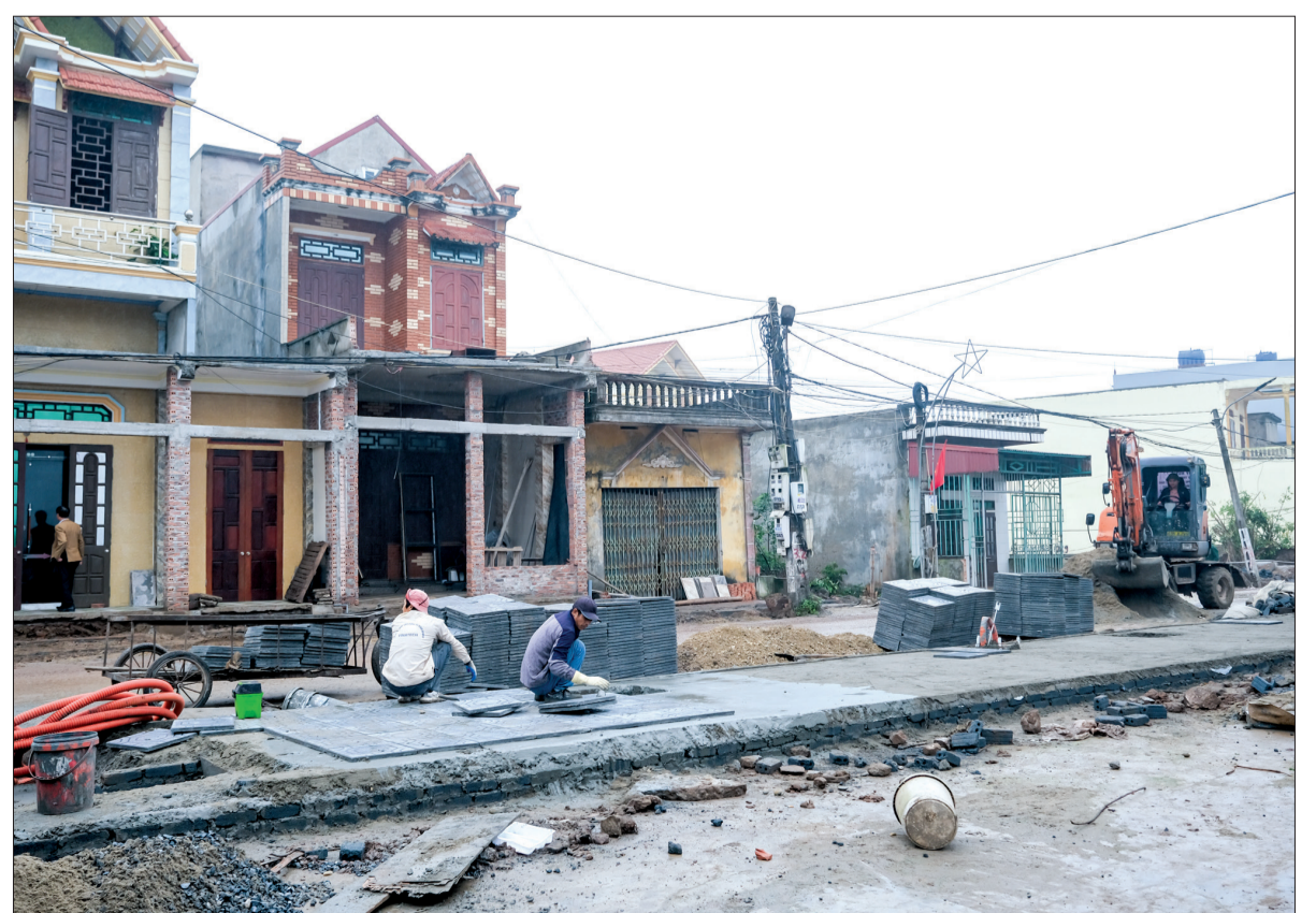
Nhiều gia đình của xã Nam Cường (Tiền Hải) tự nguyện cắt nhà phục vụ thi công tuyến đường ĐH.35.
