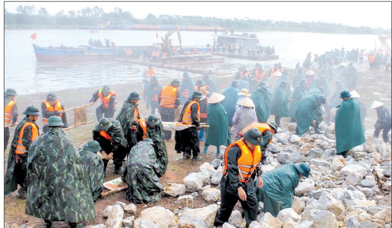
Diễn tập thực hành xử lý tình huống sạt trượt mái đê, kè tại kè hữu Lọc, xã Xuân Hòa (Vũ Thư).
