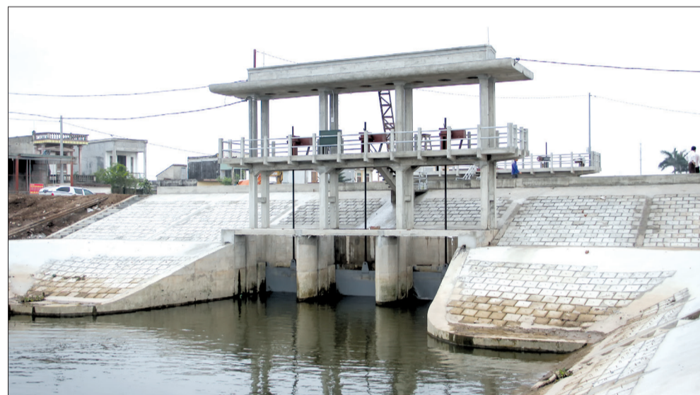
Công Thái Phúc (Thái Thụy) thi công bảo đảm đúng tiến độ, bàn giao và đưa vào sử dụng trước mùa mưa, bão năm 2017.
