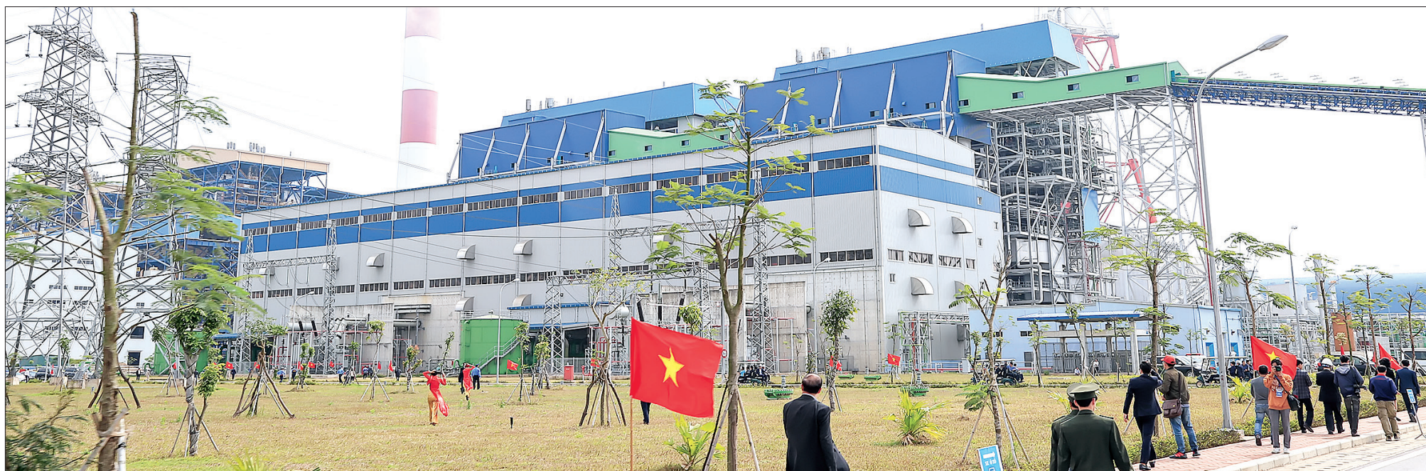
Nhà máy nhiệt điện Thái Bình.
