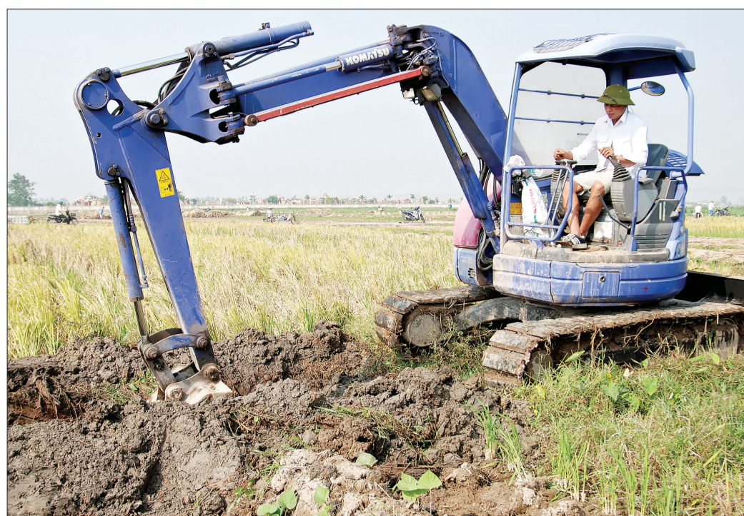
Các địa phương ở Kiến Xương huy động máy móc đẩy nhanh tiến độ làm thủy lợi đông xuân.
