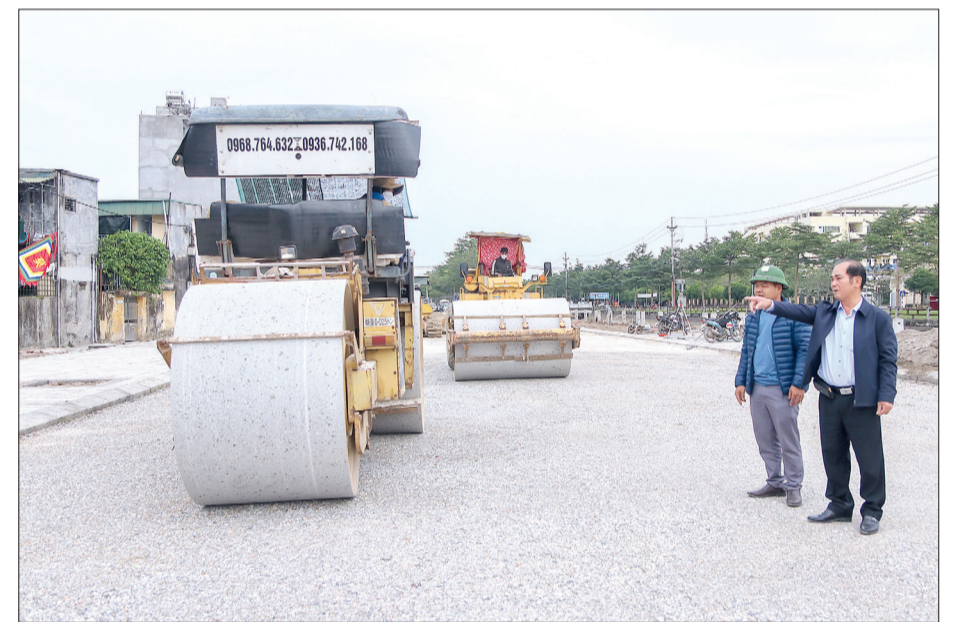
Đơn vị thi công triển khai cấp phối đá dăm trên đoạn tuyến vừa được bàn giao mặt bằng.
