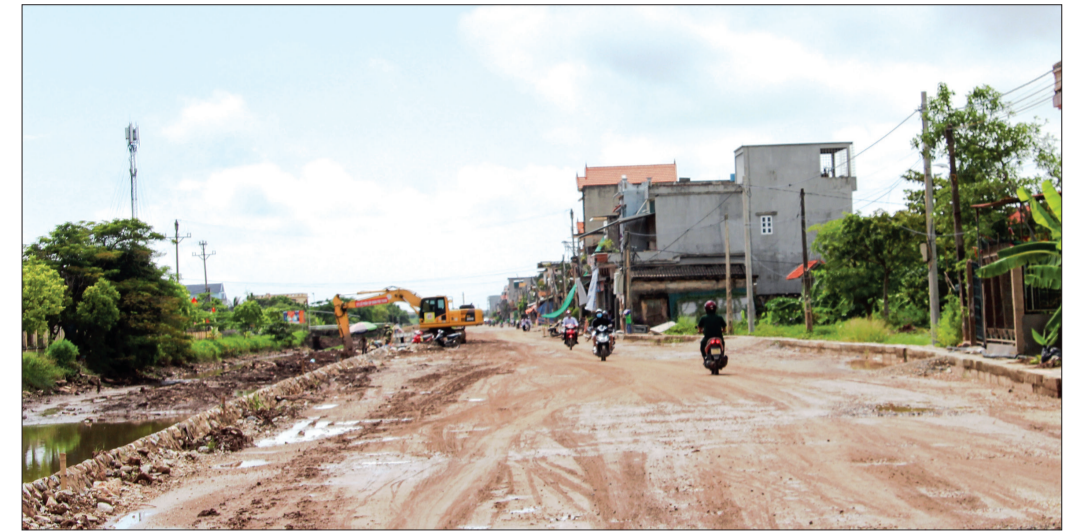
Công tác giải phóng mặt bằng đoạn qua địa phận xã Tây Tiến đã cơ bản hoàn thành, bảo đảm bàn giao mặt bằng sạch cho nhà đầu tư thi công tuyến đường 221A.
