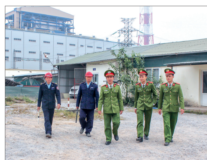
Bảo vệ Nhà máy nhiệt điện Thái Bình 2 phối hợp với lực lượng công an tuần tra bảo đảm ANTT trên công trường.
