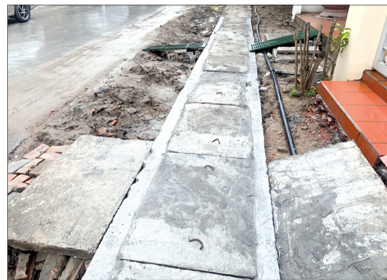
Nhiều tấm đan bê tông cũ bị nứt, vỡ đã được dỡ bỏ, thay bằng những tấm đan mới.
