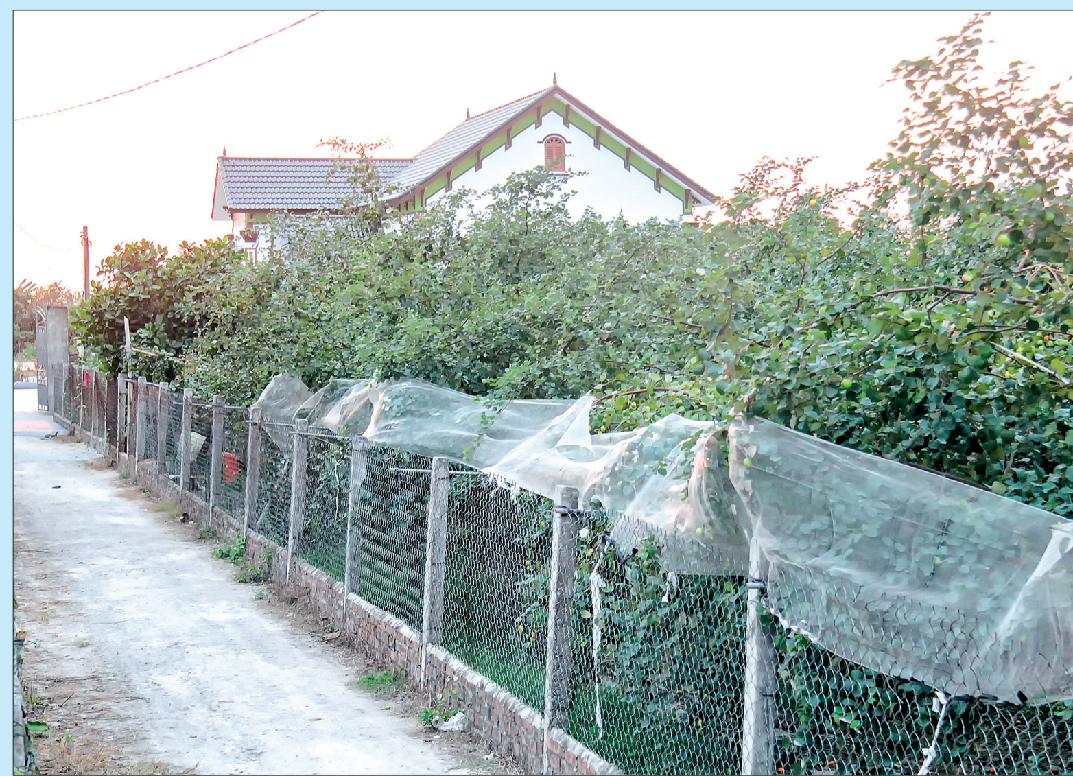
Nhà xây kiên cố trải phép trên vùng chuyển đổi thị xã Thụy Thanh (Thái Thụy).
