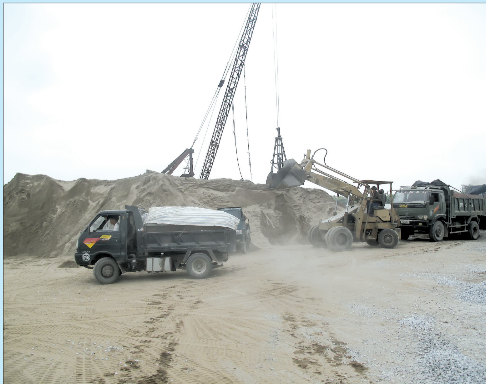
Bến bãi tập kết vật liệu xây dựng tại xã Thái Hà (Thái Thụy).
