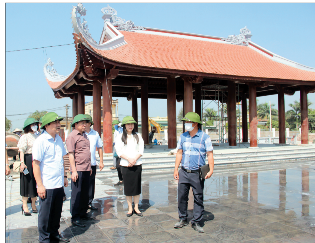
Đồng chí Nguyễn Tiến Thành, Phó Bí thư thường trực Tỉnh ủy, Chủ tịch HĐND tỉnh cùng các đồng chí lãnh đạo tỉnh kiểm tra tiến độ thi công công trình Khu lưu niệm Chủ tịch Hồ Chí Minh tại xã Nam Cường, huyện Tiền Hải.
