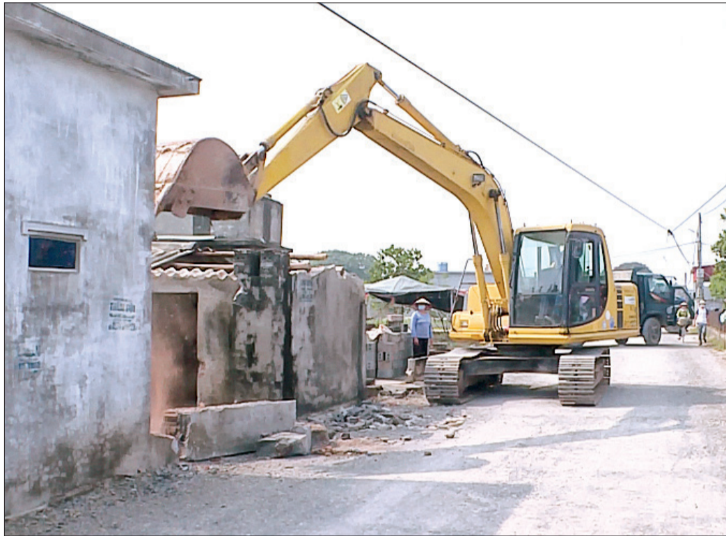
Người dân xã Bình Định (Kiến Xương) phá dỡ công trình, hiến đất giải phóng mặt bằng thi công dự án cải tạo, nâng cấp tuyến đường huyện Vũ Thắng - Bình Định.
