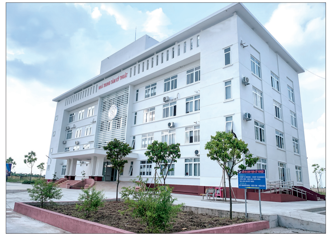
Công trình Trung tâm kỹ thuật cận lâm sàng, Bệnh viện Đa khoa Vũ Thư vừa được bàn giao đưa vào sử dụng đầu tháng 9/2022.
