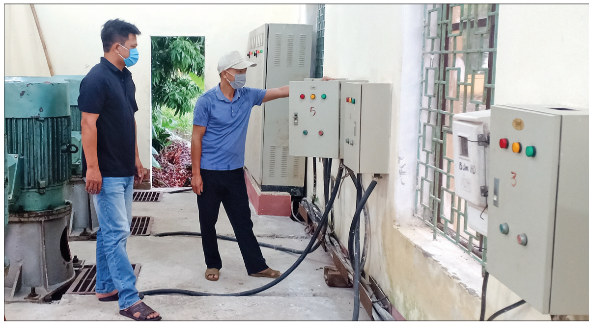
Cán bộ Xí nghiệp Khai thác công trình thủy lợi thành phố Thái Bình kiểm tra hệ thống trạm bơm Sa Lung thuộc địa phận phường Hoàng Diệu.
