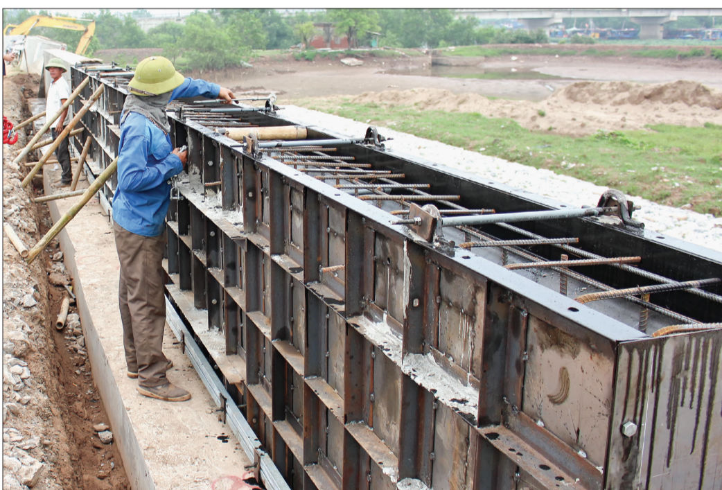
Thi công nâng cấp tuyến đê biển số 8 tại địa bàn thị trấn Diêm Điền (Thái Thụy).
