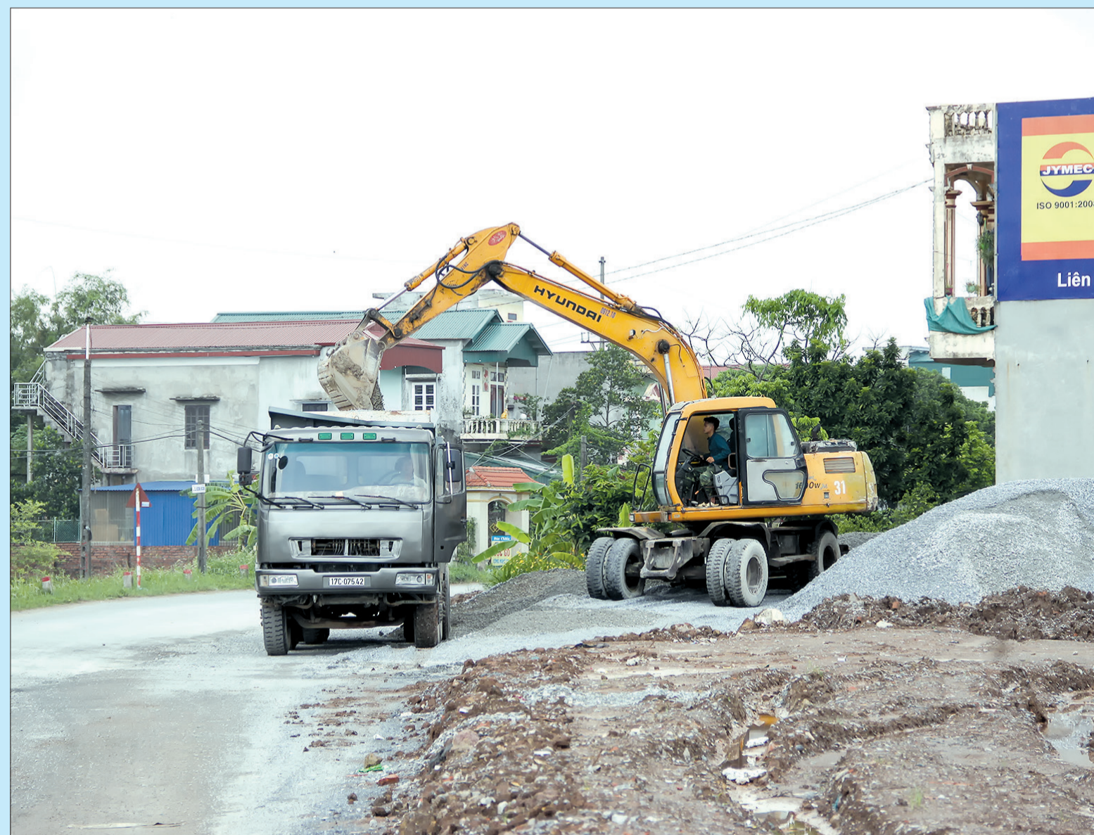
Nhà thầu huy động máy móc, nhân lực đẩy nhanh tiến độ gói thầu RAI/CP13 dự án nâng cấp, cải tạo quốc lộ 39 đoạn Triều Dương - Hưng Hà.
