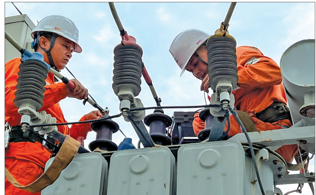
Điện lực Quỳnh Phụ tổ chức duy tu, bảo dưỡng hệ thống lưới điện bảo đảm cấp điện ổn định mùa nắng nóng.
