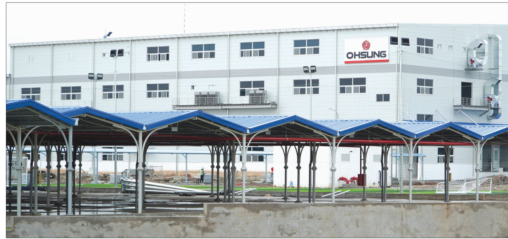
Nhà máy sản xuất của Công ty TNHH Ohsung Vina Thái Bình đi vào hoạt động sau 8 tháng đầu tư xây dựng nhà xưởng và lắp đặt máy móc.
