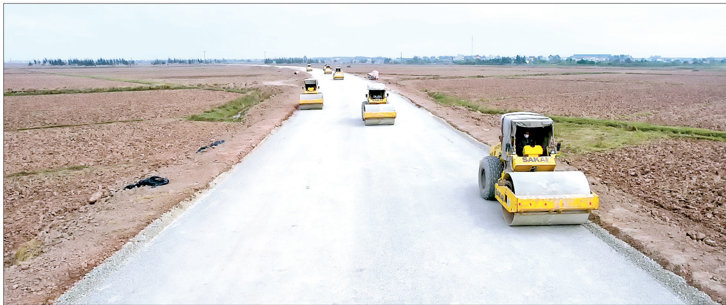
Thi công tuyến đường bộ ven biển, địa phận huyện Tiền Hải.
