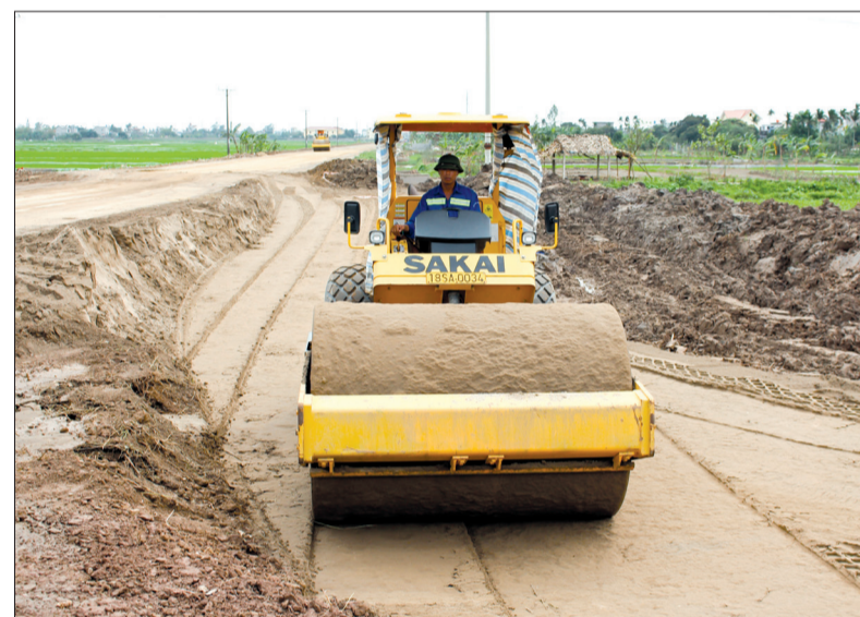
Thi công đường ĐH.91 giao với quốc lộ 39 mới.
